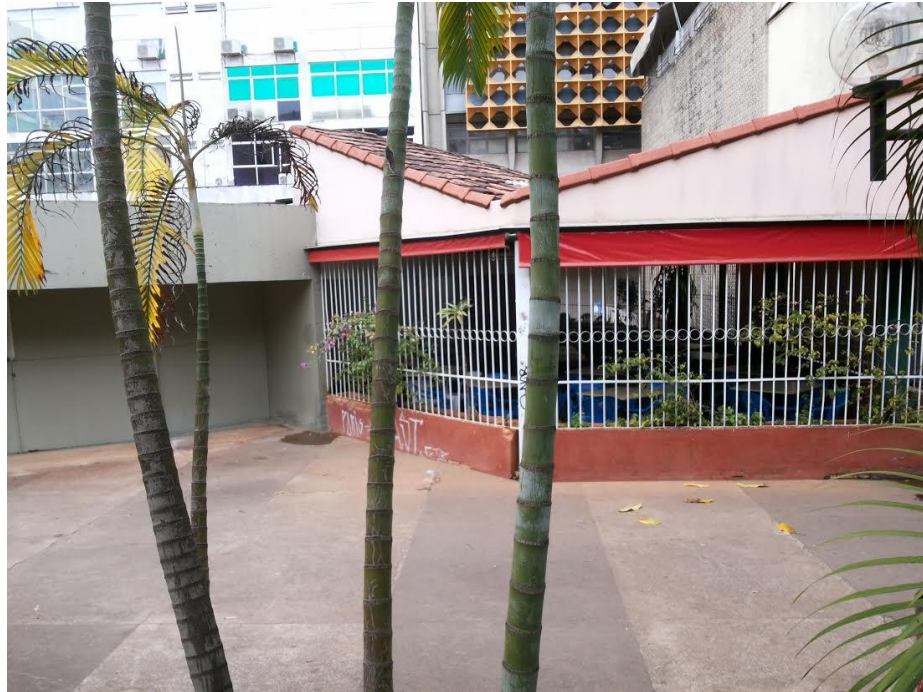
Imagem 02. Piso Térreo. Avanço do Villa's Restaurante e Lanches Ltda, lateral.
