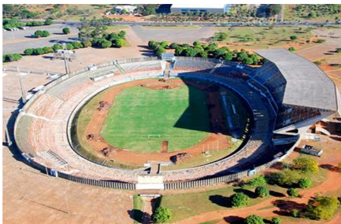
Figura 2 – Estádio Mané Garrincha antes das obras
