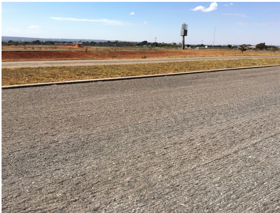
Figura 4. Parte da pista, após remoção da camada asfáltica
