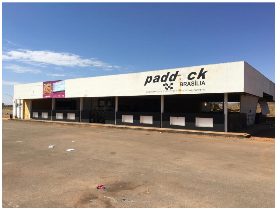
Figura 17. Estrutura do restaurante
