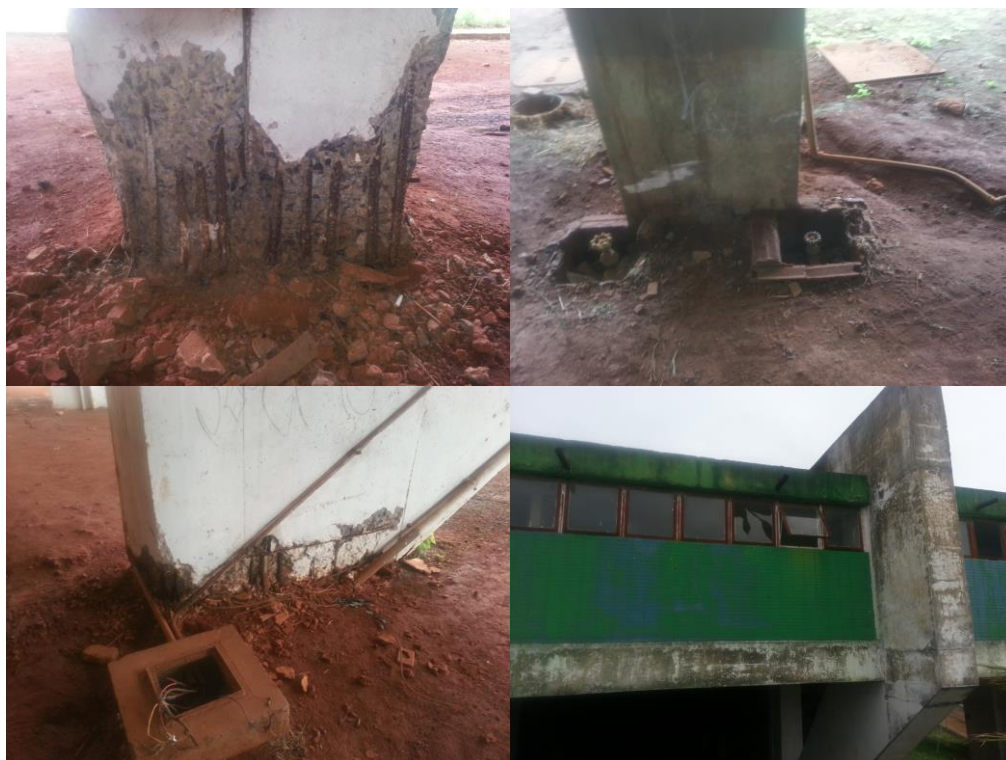
Figura 8. Detalhes da estrutura da arquibancada coberta
