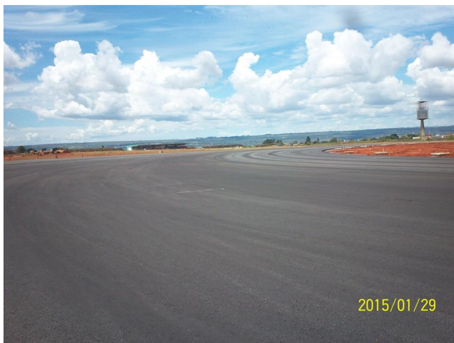
Figura 5. Parte da pista recapeada
