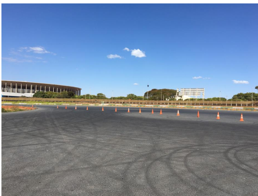
Figura 3. Parte da pista, após recapeamento
