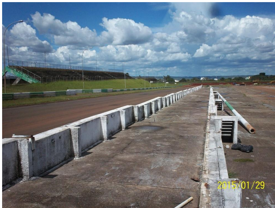
Figura 9. Localidade onde foram demolidos os boxes
