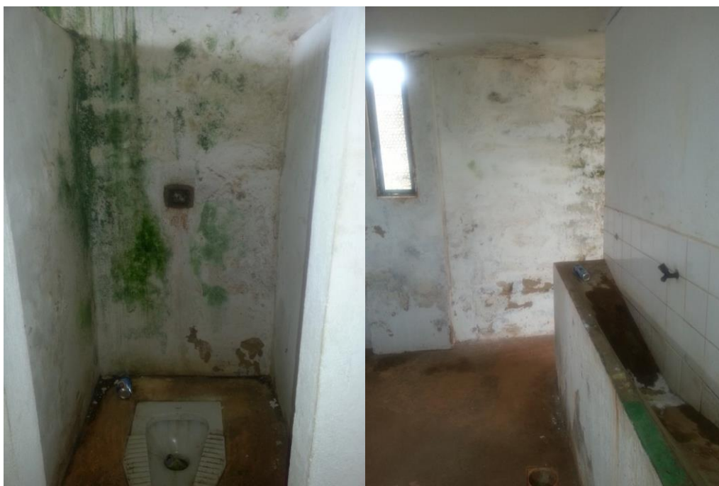
Figura 22. Detalhes dos banheiros 2
