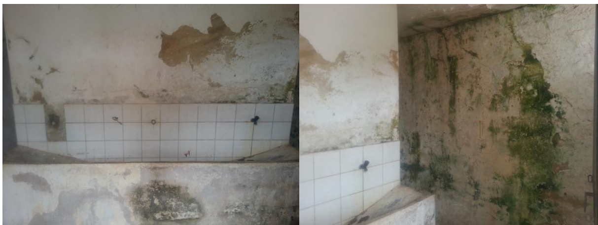
Figura 21. Detalhes dos banheiros
