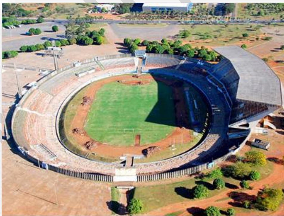
Figura 2 – Estádio Mané Garrincha antes das obras
