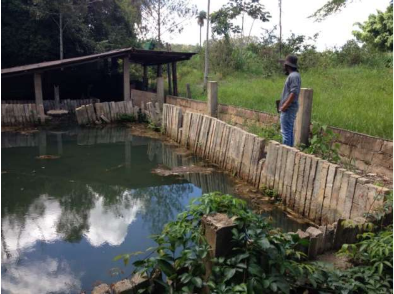
Foto 16 – Reservatório de captação de água dos drenos no córrego Brejo do Lobo.
