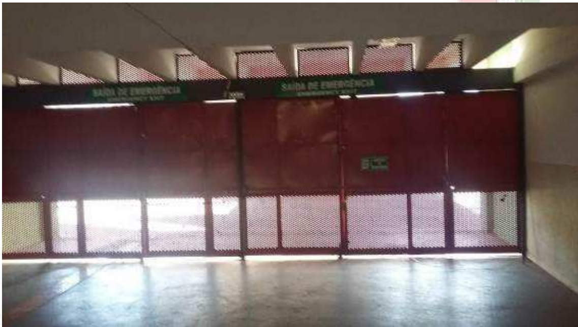
Portões de acesso aos pares e com a função de saída de emergência.
