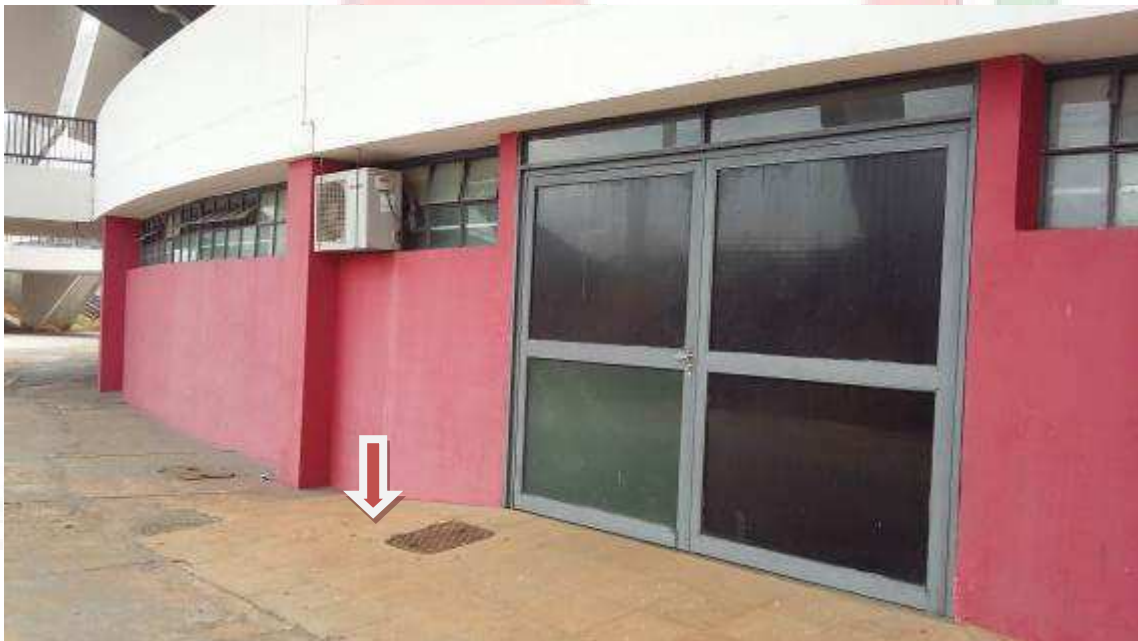
Pintura de piso e tampas das caixas de passagens (seta vermelha)
