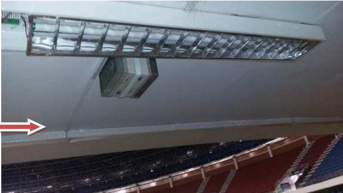
Sistema iluminação com execução provisória. Seta vermelha
