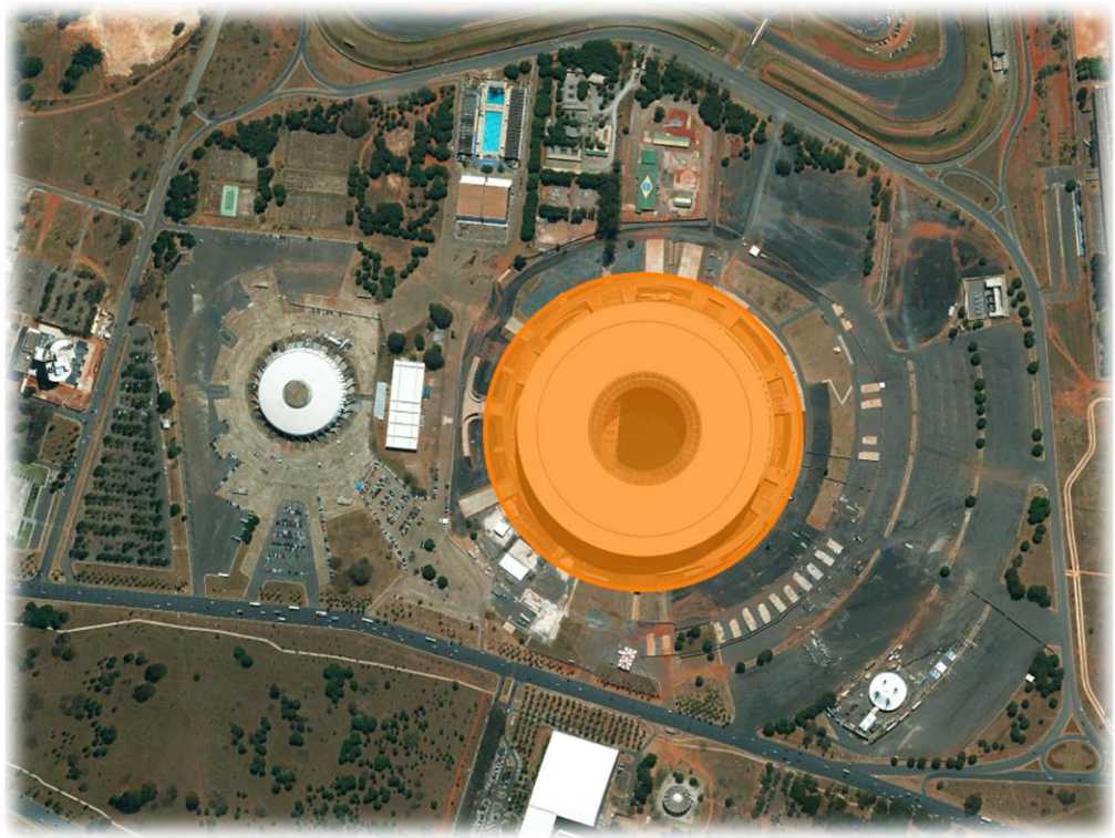
Figura 3 – Vista aérea do estádio no complexo esportivo
