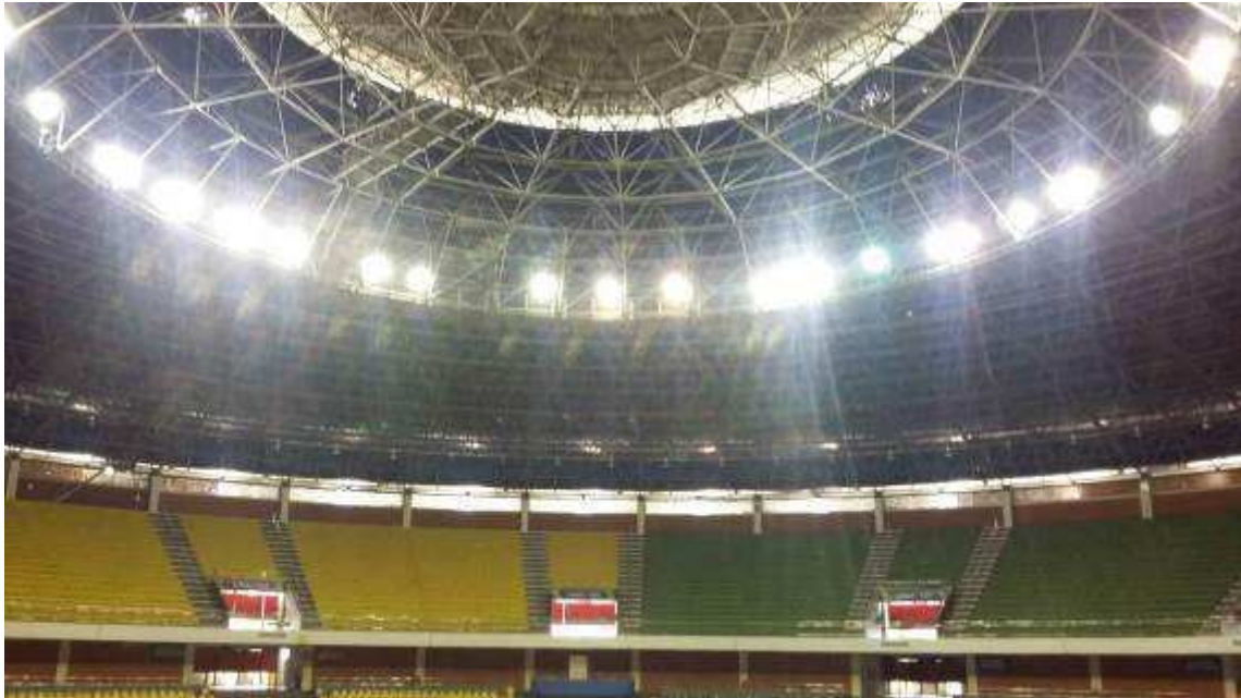
Vista parcial do sistema de cobertura espacial do estádio, apresentando varias anomalias com vazamento, durante as chuvas podendo evoluir para perda de eficiência de suporte da estrutura, já que a mesma e toda em peça metálica tubular executada em fixação mecânica.
