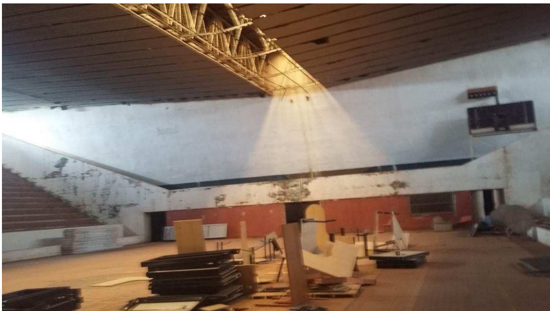
Figura 05 - Foto interna do Ginásio, mostrando a piscina toda coberta com o tablado de madeira e o telhado em estrutura metálica, e ao fundo uma cortina em concreto armado.
