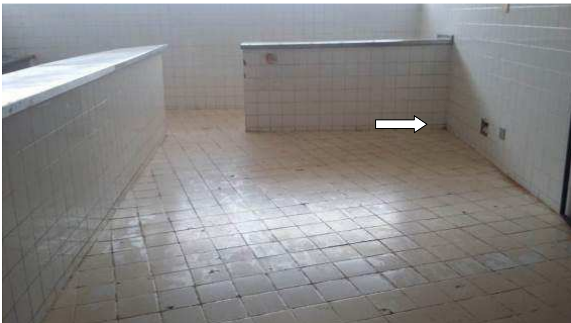
Ambiente já com todo o sistema de revestimento comprometido, anomalias nas instalações. Seta branca
