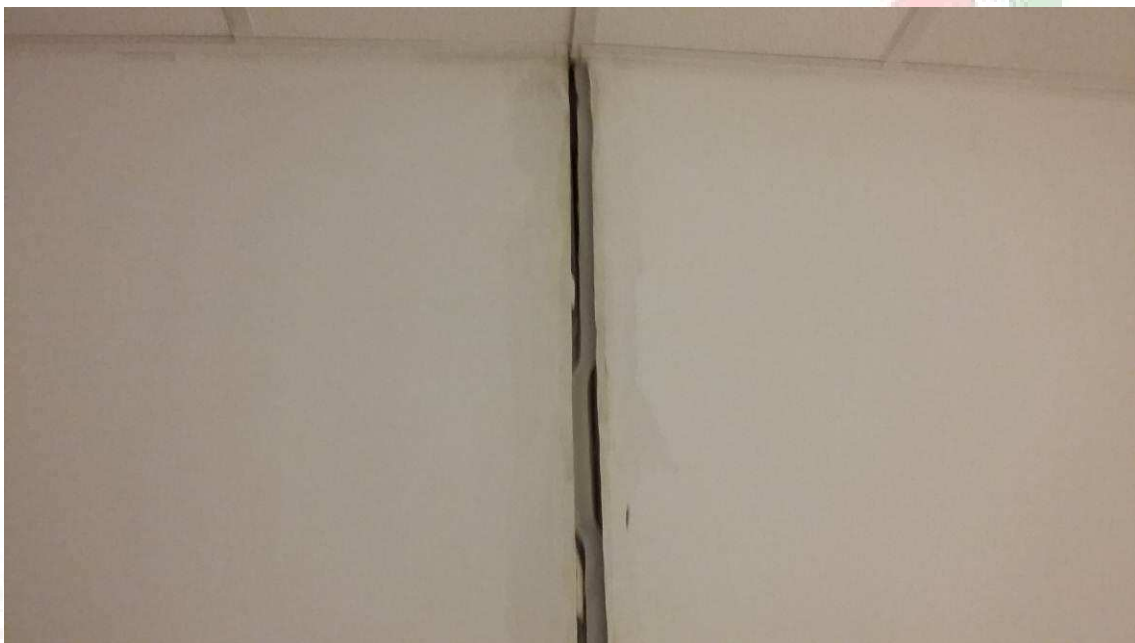
Figura 05 – Junta de dilatação na horizontal executado com material inadequado deixando evidente a fadiga do mastique, permitindo a passagem de água durante a limpeza do pavimento superior, conforme mostra na figura abaixo.
