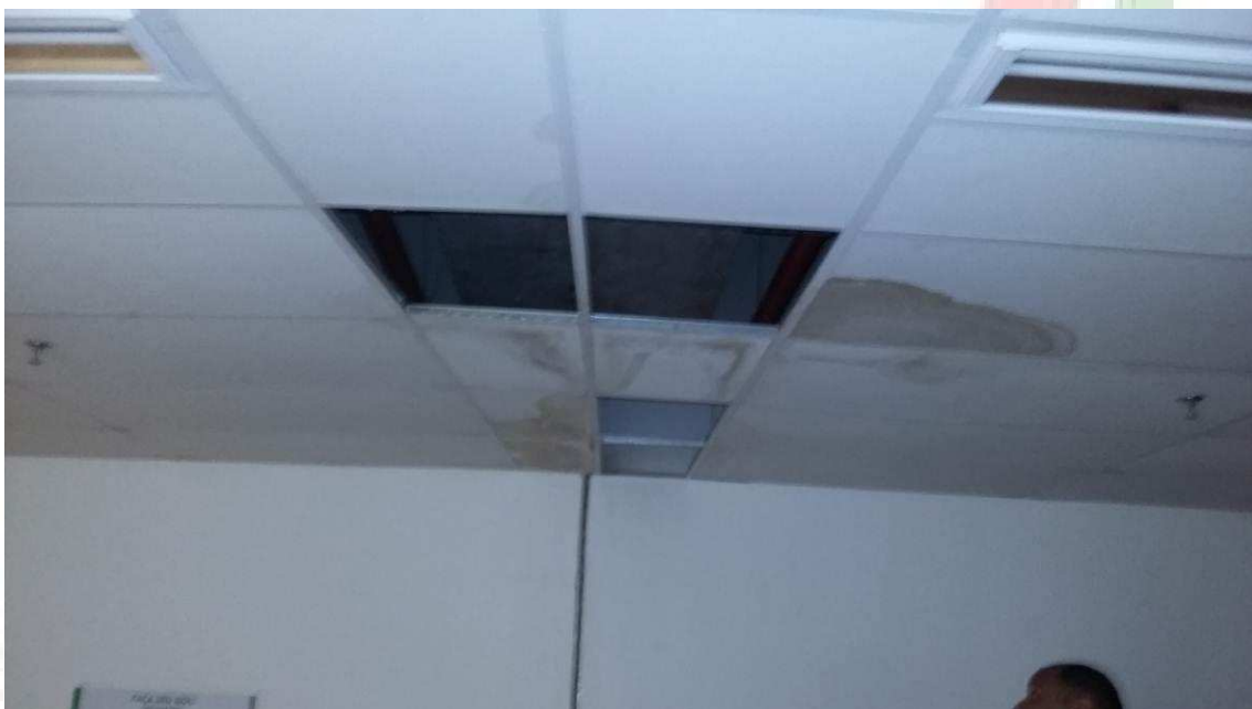
Figura 07 – Forro danificado devido à passagem de água pelas juntas de dilatação isto acontece em todos os raio, danificando os revestimentos inferiores.
