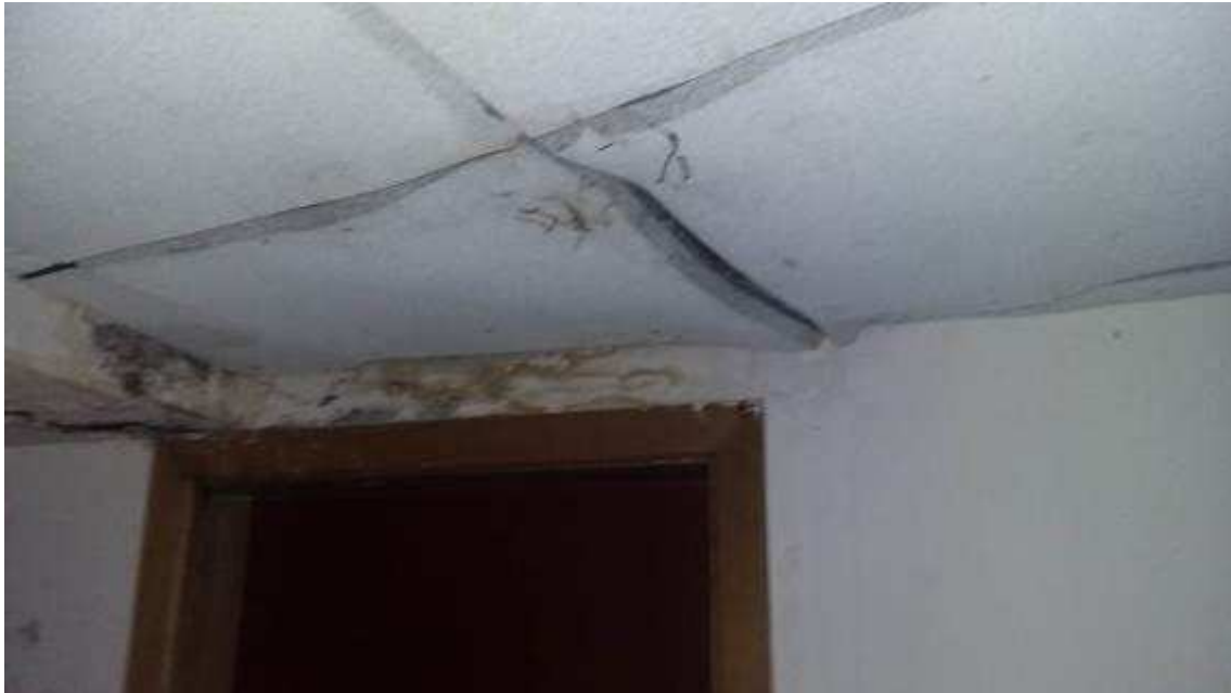
Sistema de proteção acústica sem eficiência, forma de norma e um risco para os usuários
