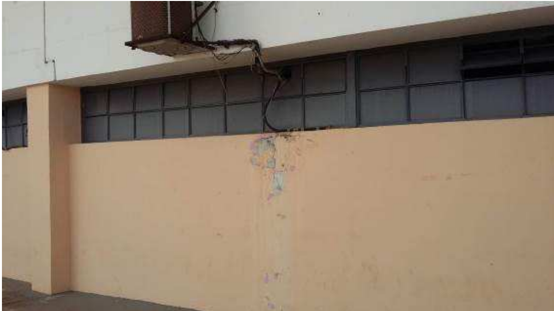
Aparelho de ar condicionado com instalação má executada, danificando a fachada, indicação aparecimento de patologia na edificação.
