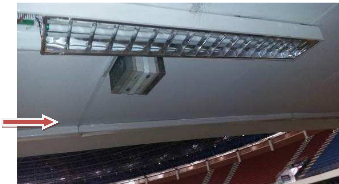
Sistema iluminação com execução provisória. Seta vermelha
