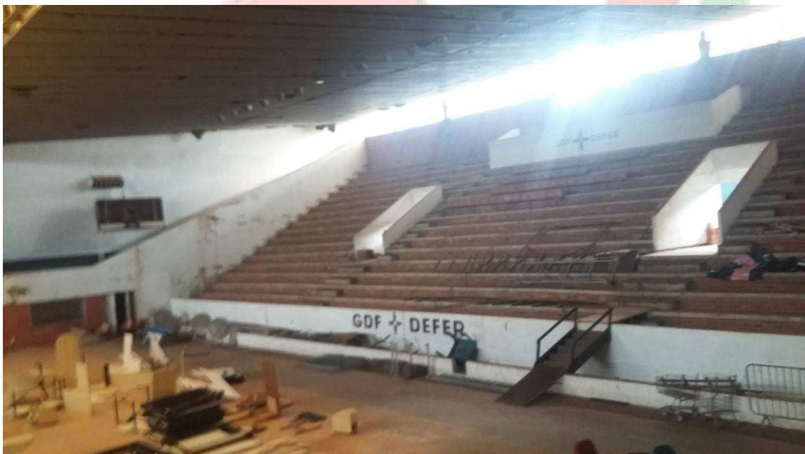
Figura 03 – Área interna da arquibancada, ao centro a piscina lacrada com tablado de madeira.
