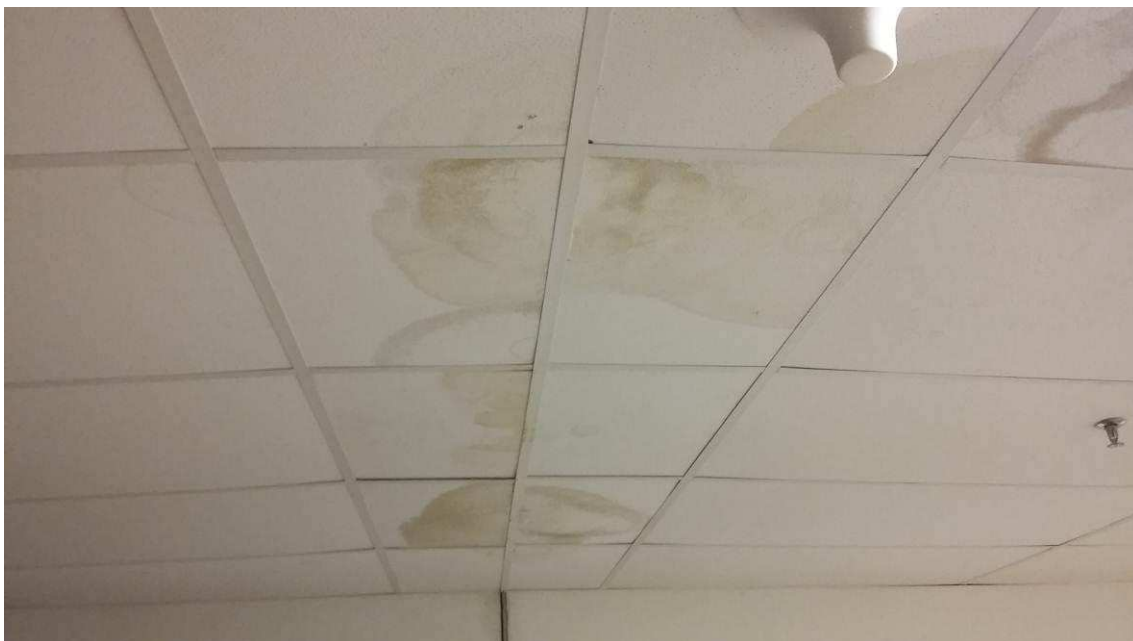
Figura 08 – Forro danificado devido à passagem de água pelas juntas de dilatação isto acontece em todos os raios, danificando os revestimentos inferiores.
