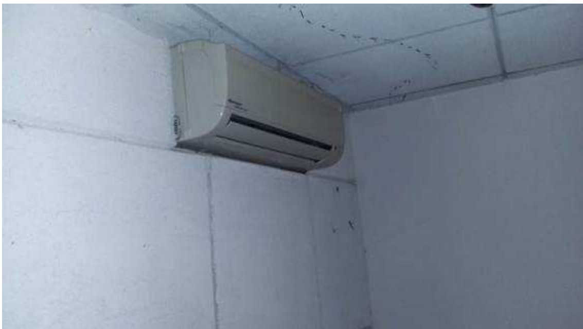
OS aparelhos de ar condicionado apresenta aspecto de má conservação devido ao próprio tempo de uso e falta de limpeza e correções preventivas.
