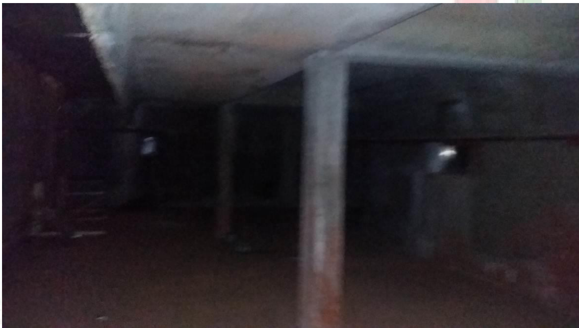
Figura 10 – Hall de chega ao duto de serviço com pilares em concreto armado.
