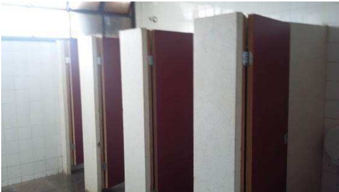
Divisórias dos banheiros em granitina, bacia sanitária sem o tampo.
