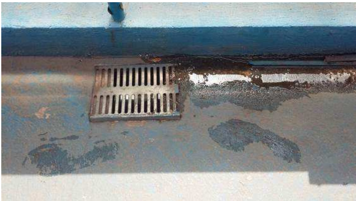
Acumulo de água próxima a captação de água pluvial, grelha com parte danificada.
