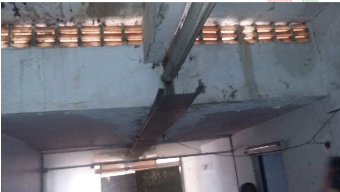
Figura 08 – Estrutura em concreto armado com vão preenchido em alvenaria. Porta de acesso ao anel de prestação de serviço da piscina.
