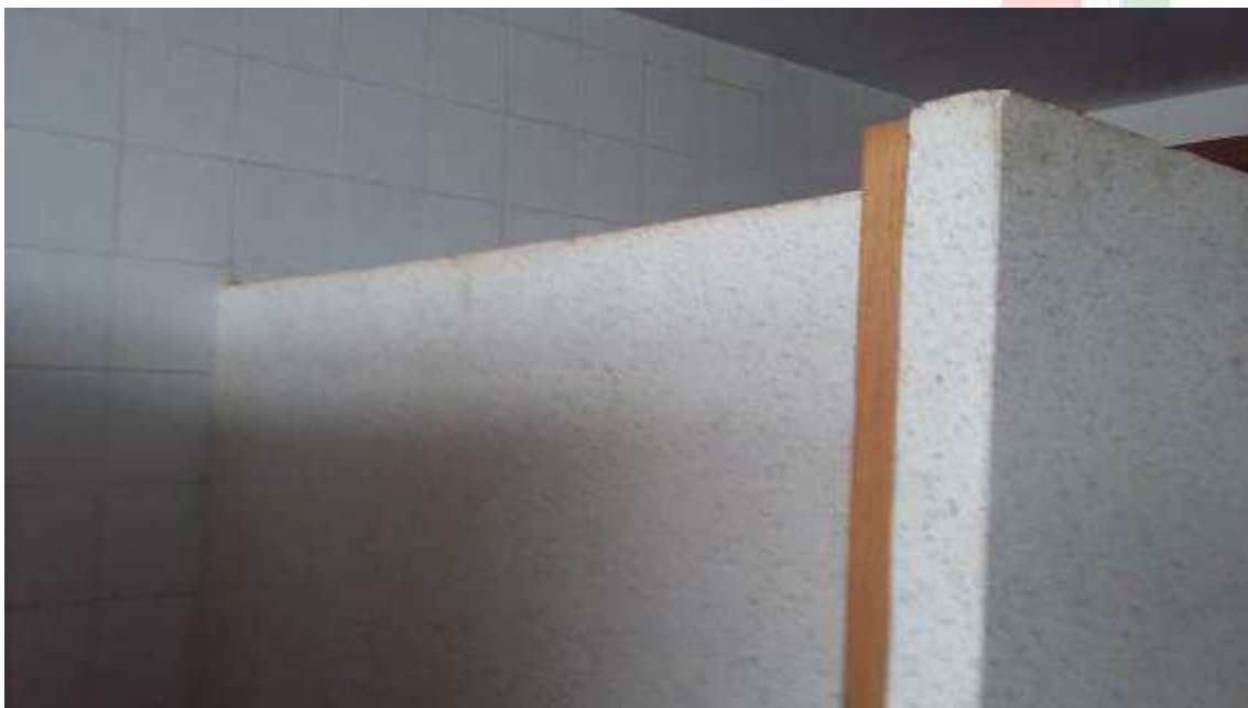
Divisórias dos banheiros em granitina, bacia sanitária sem o tampo.
