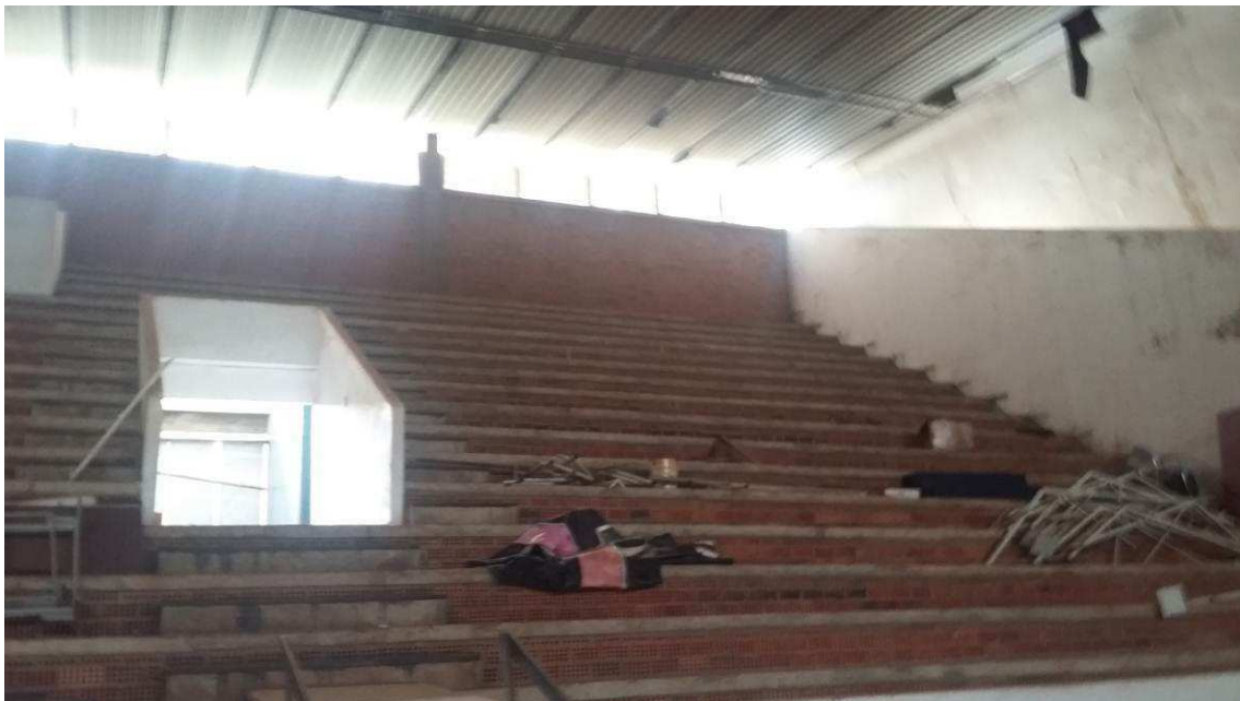
Figura 07 - Abertura de Acesso lateral do público ao interior do estádio. Arquitetura em concreto armado
