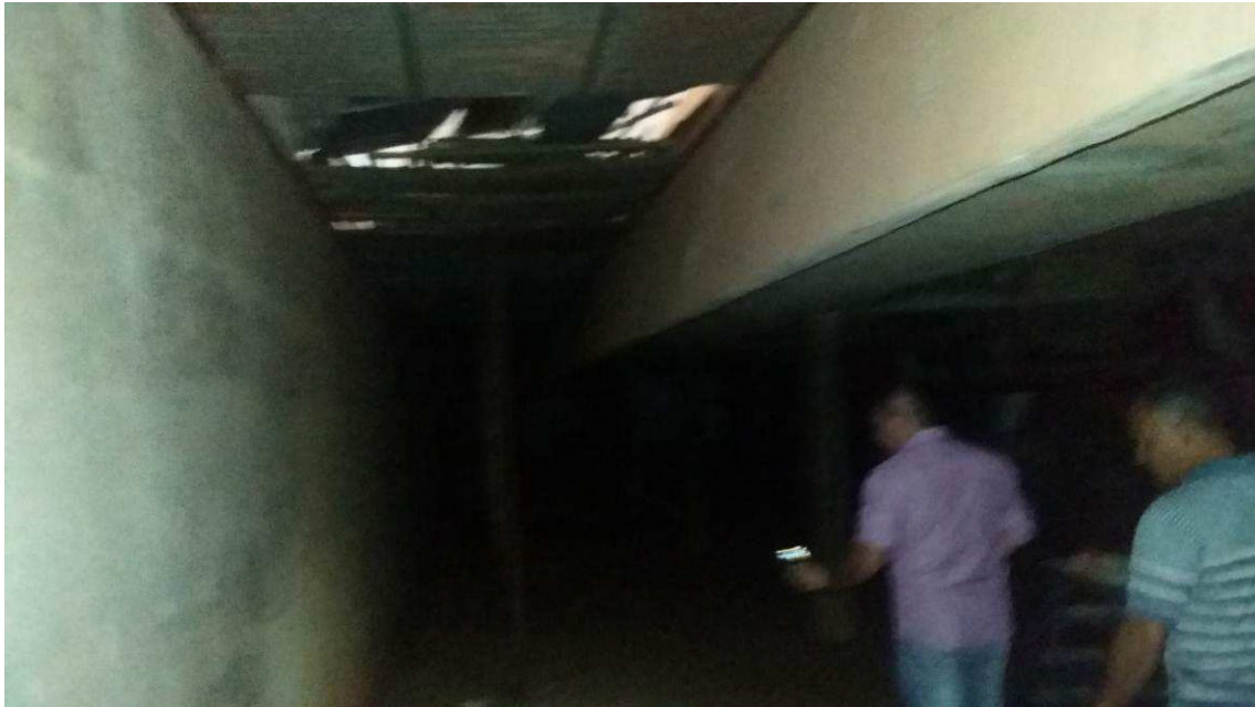
Figura 13 - Duto com paredes em concreto armado em todo o perímetro da piscina
