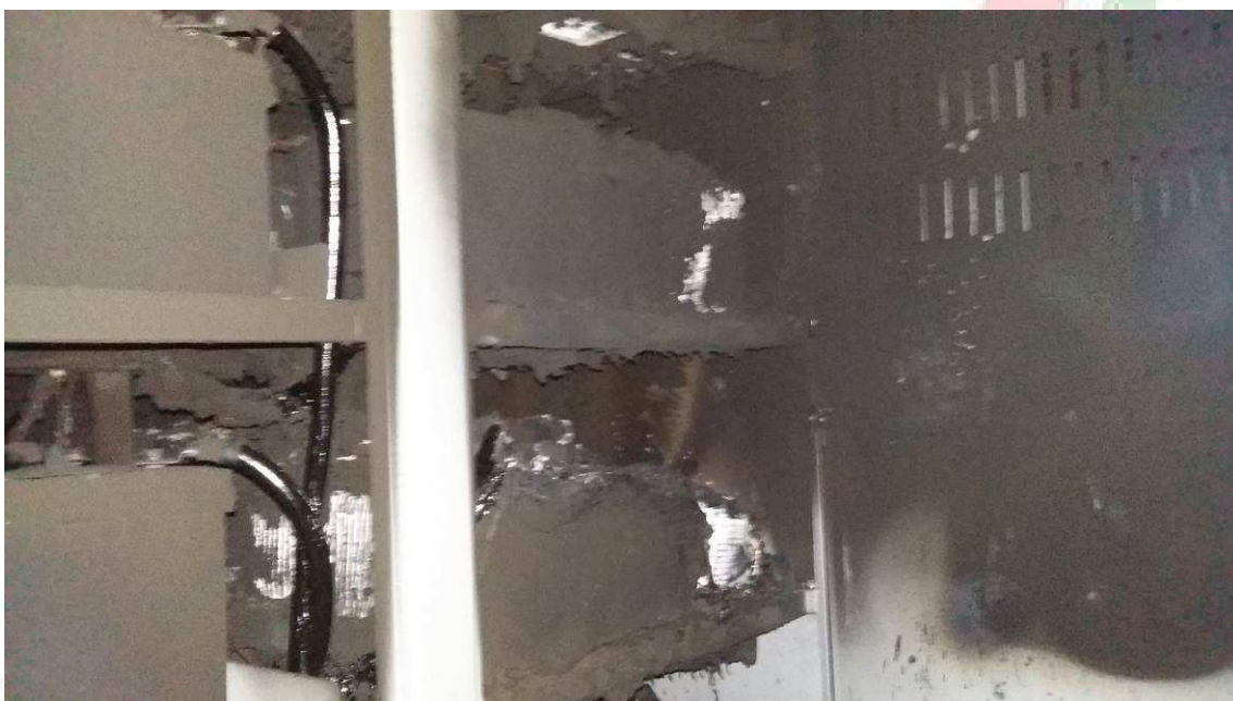
Figura 11 – Nesta foto mostra o incêndio na casa das baterias – Nobreak onde houve a queima de 32 unidades de baterias em duas torres..
