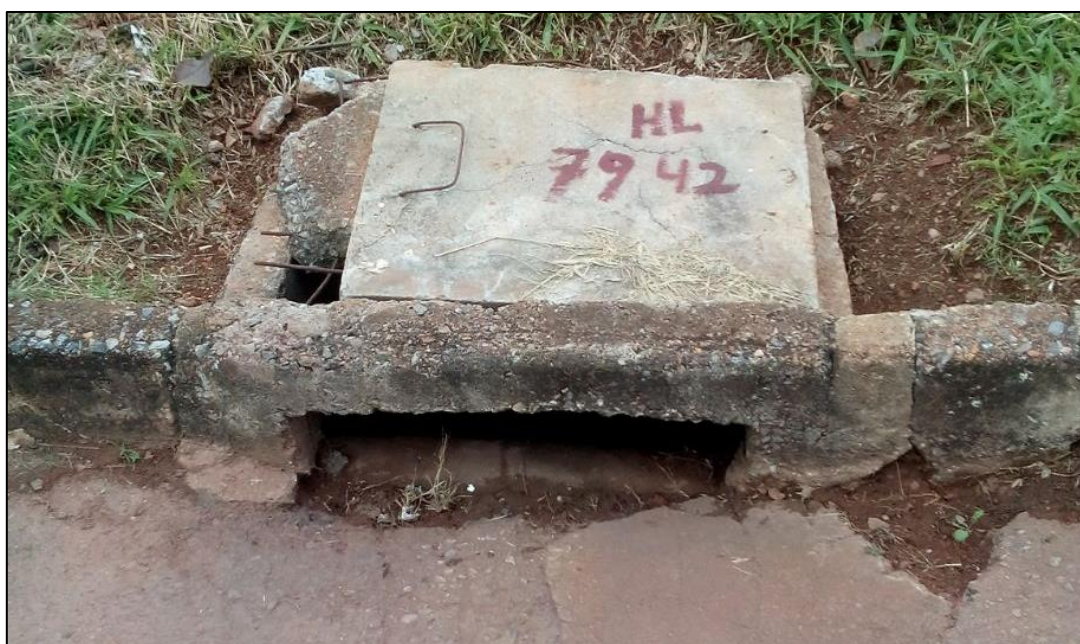
Figura 10 – Condições das bocas de lobo existentes
