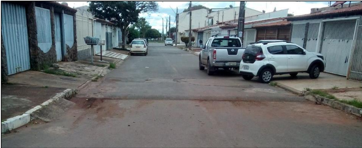
Figura 13 - Falta de captações nas embocaduras das vias transversais
