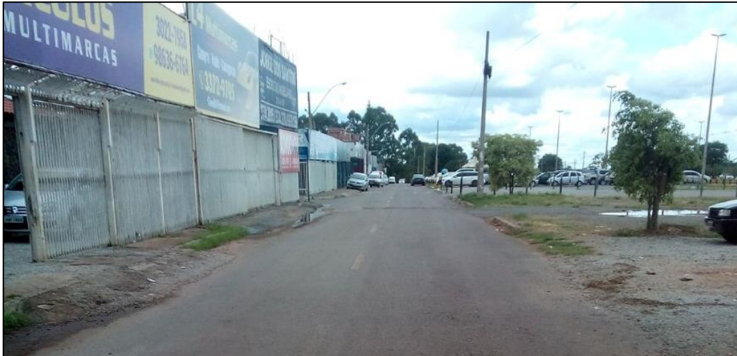
Figura 11 – Trechos de via sem captações
