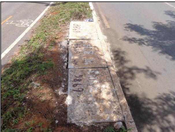
Foto 3 – Equipamento Público Urbano (boca de lobo).
