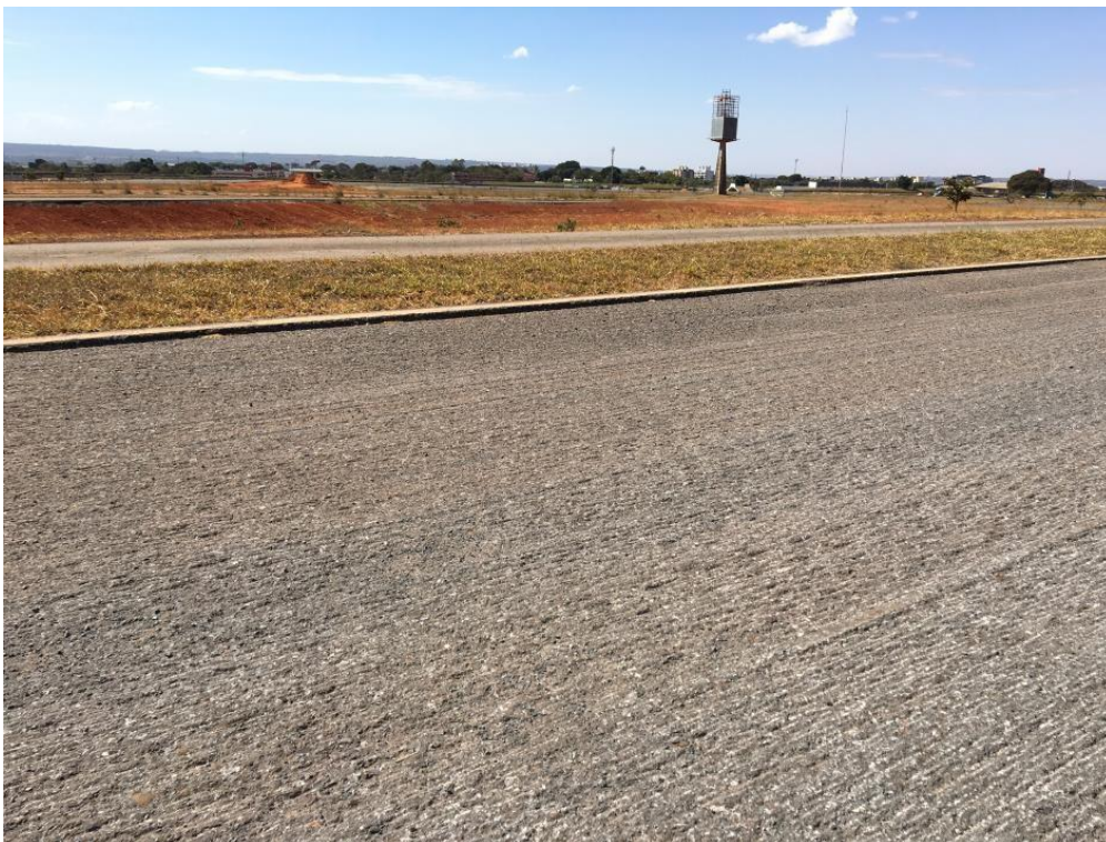
Figura 7: Trecho da pista após remoção da camada asfáltica.
