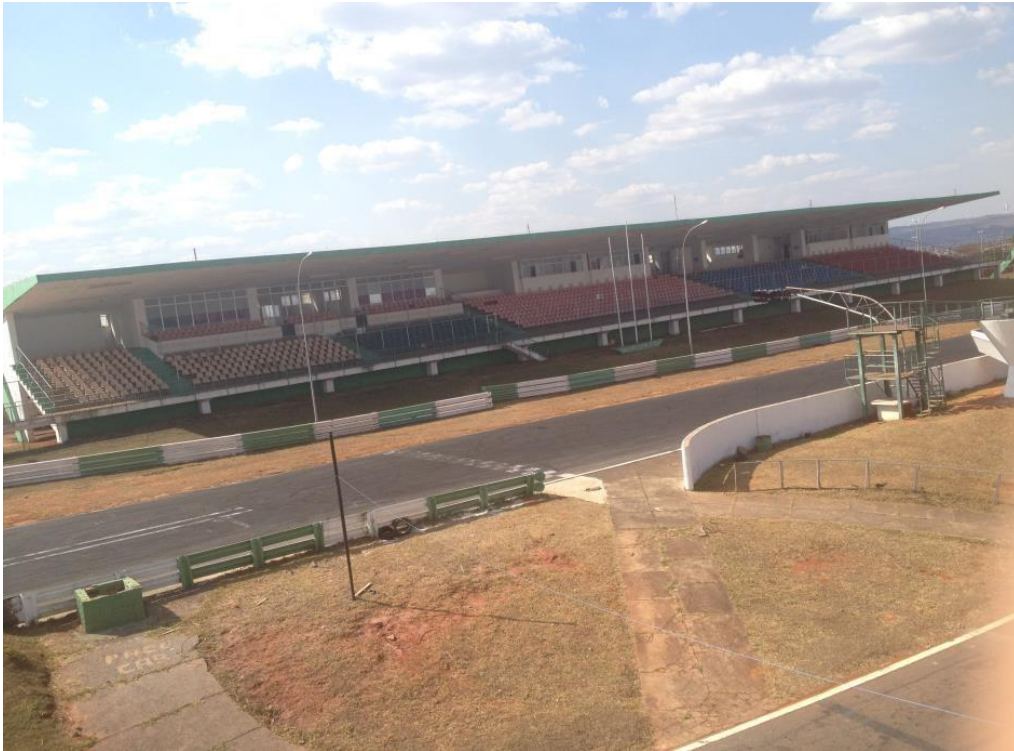
Figura 9: Vista externa da arquibancada coberta.
