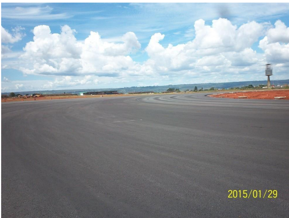
Figura 8: Trecho da pista repaveado.
