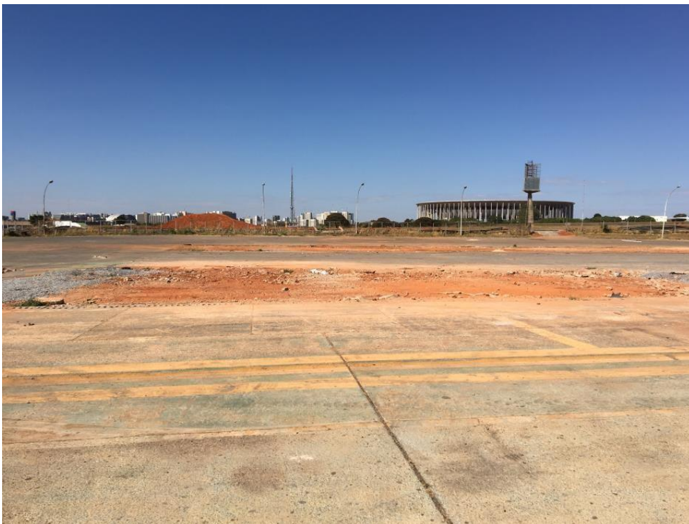
Figura 13: Localidade onde foram demolidos os boxes.
