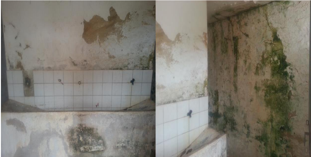
Figura 21: Detalhes dos banheiros.
