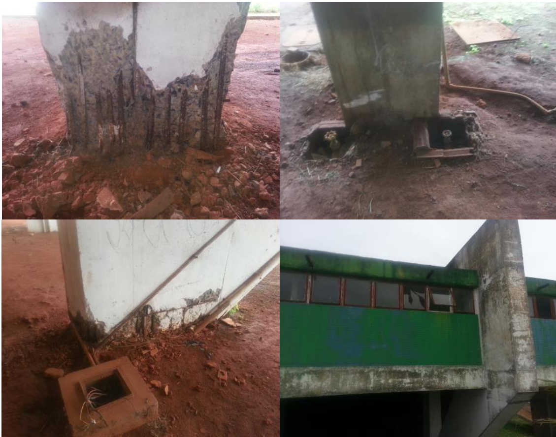
Figura 11: Detalhes da estrutura da arquibancada coberta.
