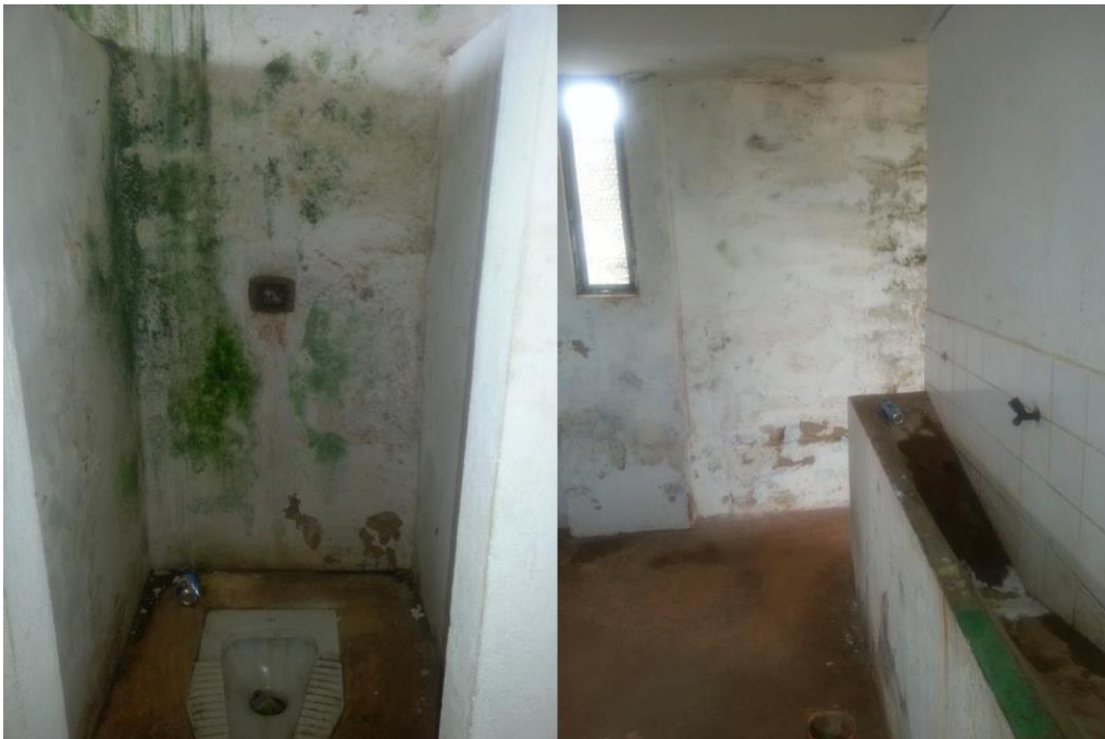
Figura 22: Detalhes dos banheiros.
