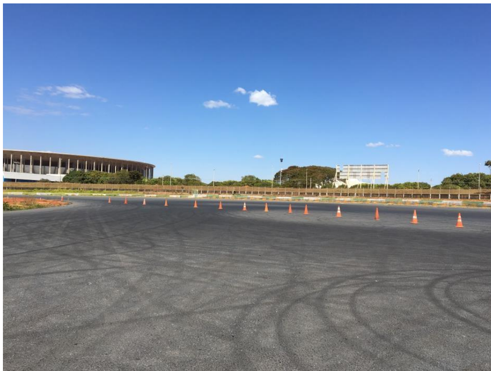
Figura 6: Trecho da pista recapeado.
