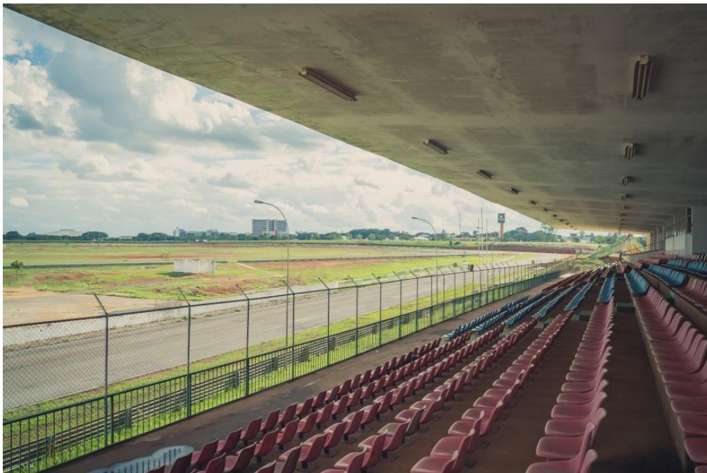
Figura 10: Vista interna da arquibancada coberta.
