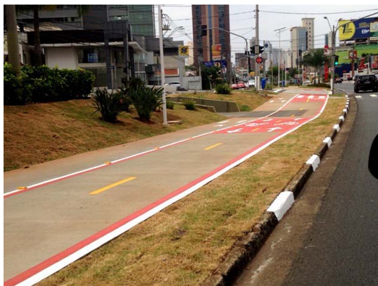
Figura 13 - Pintura da ciclovia
