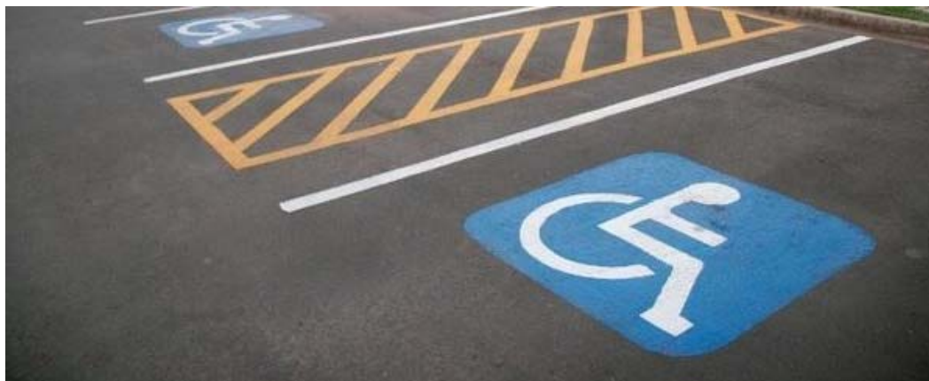
Figura 11 - Pintura para estacionamento exclusivo e para ciclovia na calçada
