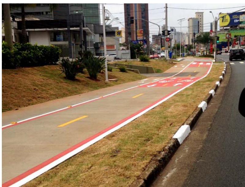
Figura 12 - Pintura da ciclovia
